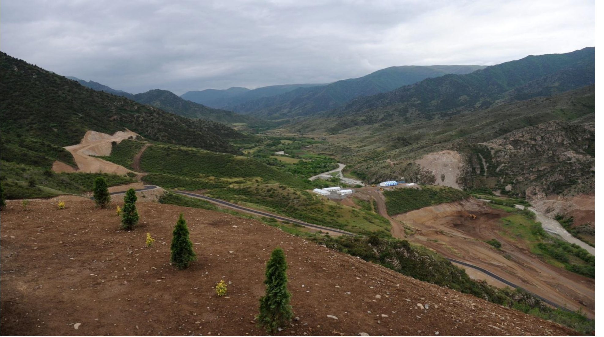
Şekil 1.2 Şamkirçay su anbarının tikiləcəyi yer
