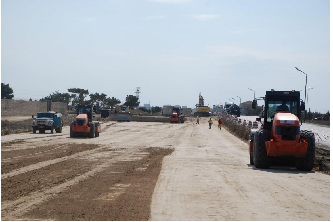
Şəkil 12. Qala-Pirallahi avtomobil yolunda əhəngdaşı materialından əsasın əlavə layının inşası
