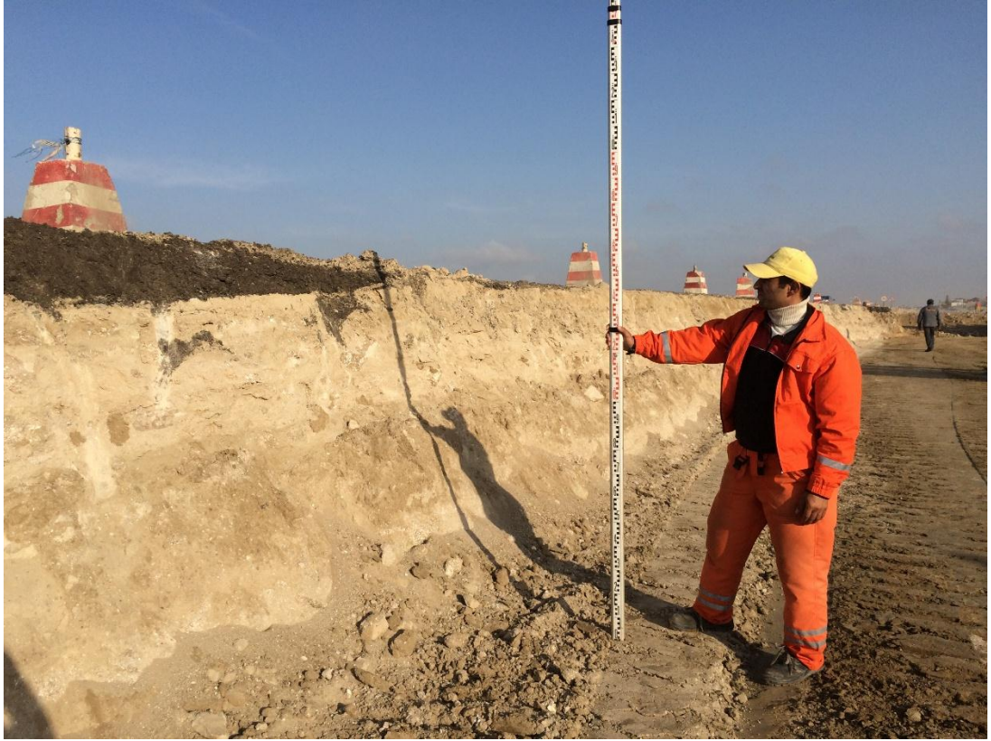
Şəkil 6. Qala-Pirallahı avtomobil yolunda qalınlığı 2m-dən artıq yararsız qrunnun çıxarılması
