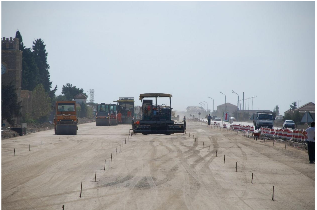
Şəkil 10. Qala-Pirallahı avtomobil yolunda əhəngdaşı-qırmadaş qarışığının döşənməsi və ilkin kipləşdirilməsi
