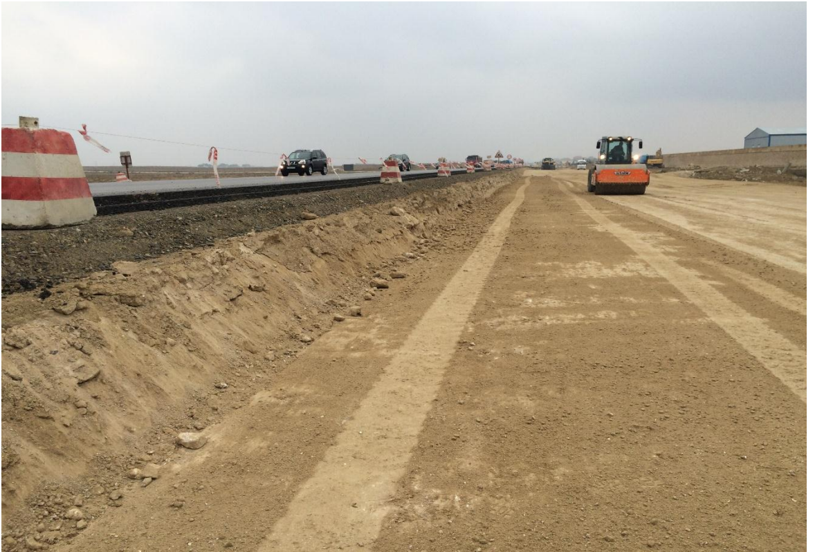
Şəkil 9. Qala-Pirallahı avtomobil yolunda yol geyiminin inşası üçün torpaq yatağının əhəngdaşı materialı ilə hazır vəziyyətə gətirilməsi.
