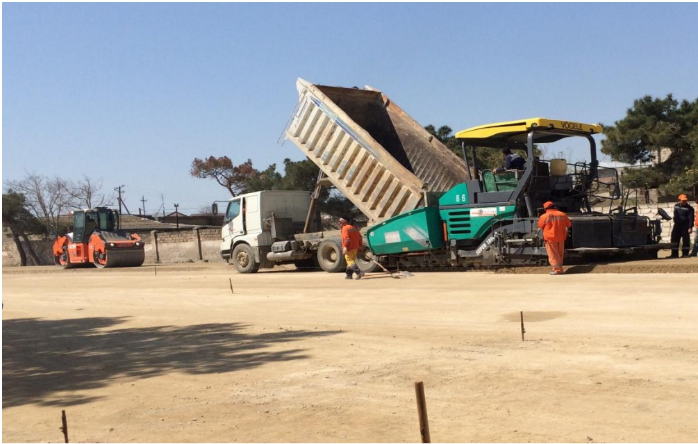
Şəkil 13. Qala-Pirallahı yolunda əhəngdaşı-qırmadaş materialının döşənməsi və kipləşdirilməsi.
