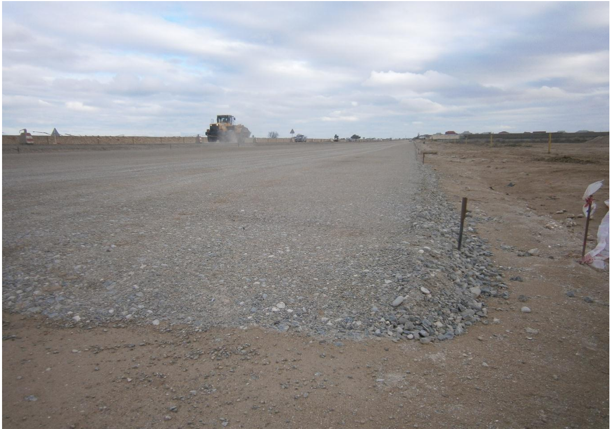
Şəkil 14. Qala-Pirallahi avtomobil yolunda əsasın üst layının tikintisi üçün kipləşdirilərək hazır vəziyyətə gətirilmiş əhəngdaşı-qırmadaş materialından ibarət əsasın alt layı
