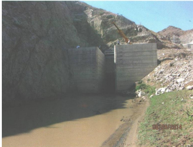
ı anbarına suyun yığılması üçün Nəqledici tunelin girişinin bağlanması (08.09.2014-cü il)
