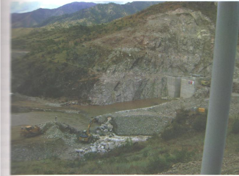
Şəmkirçay çayının suyunun Nəqledici tunelə yönəldilməsi (16.07.2010-cu il)
