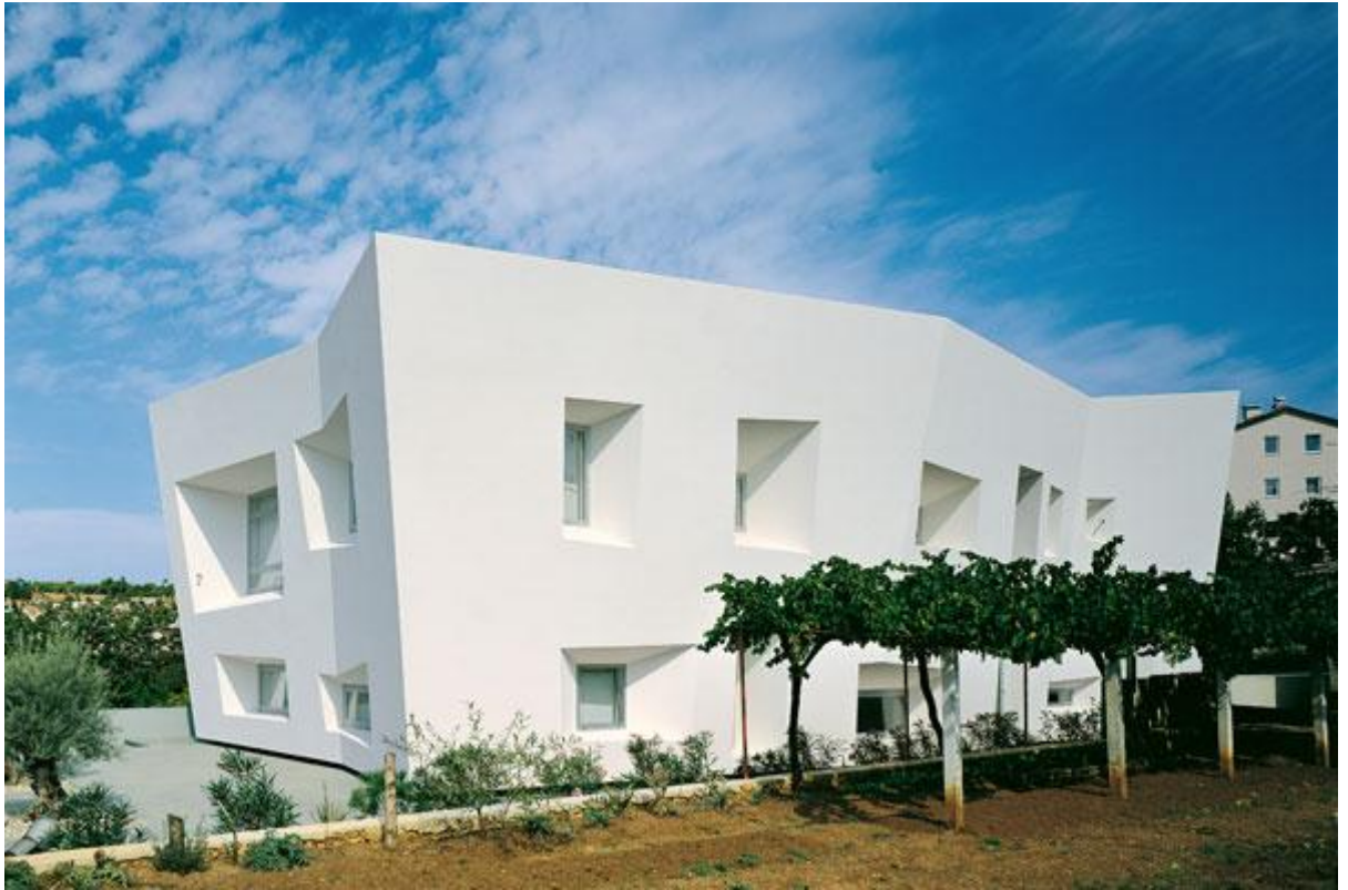
Kommersiya binası. Pula, Xorvatiya. Özünütəmizləyən boya (Lotus Effekt)
